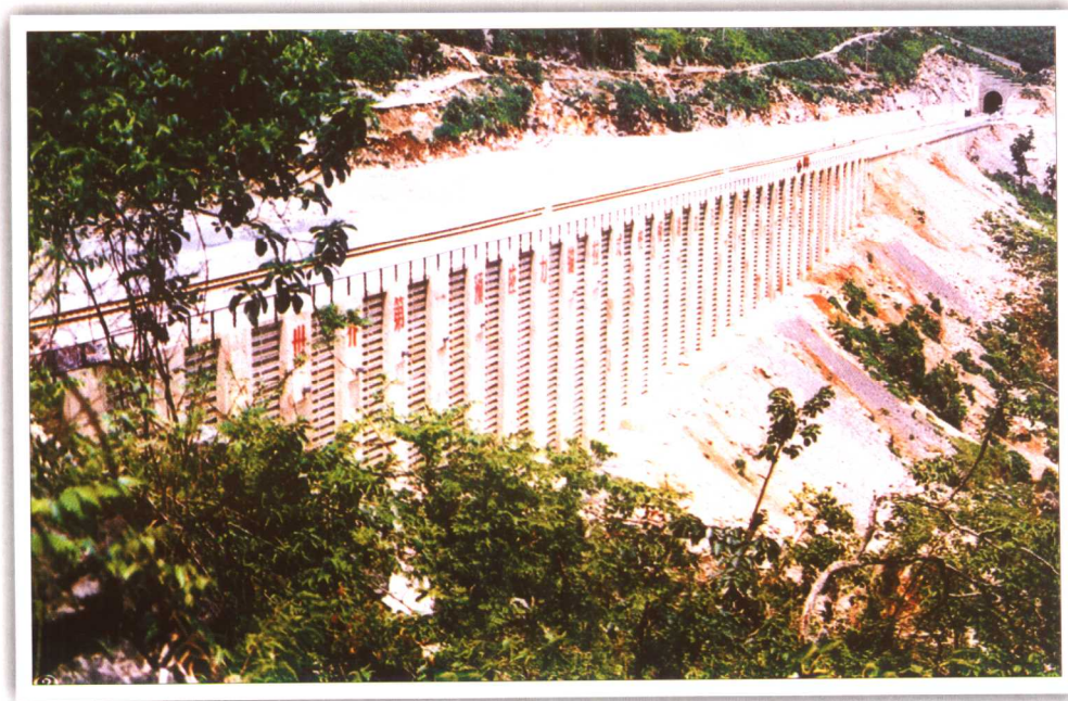
石头寨锚拉式桩板墙
