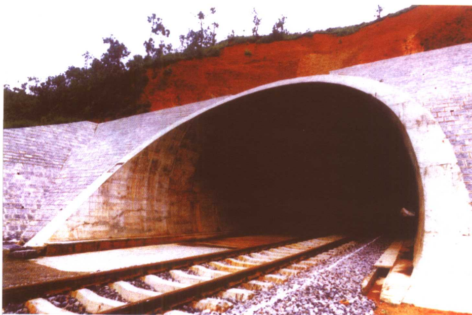
乐善村2号双线隧道
