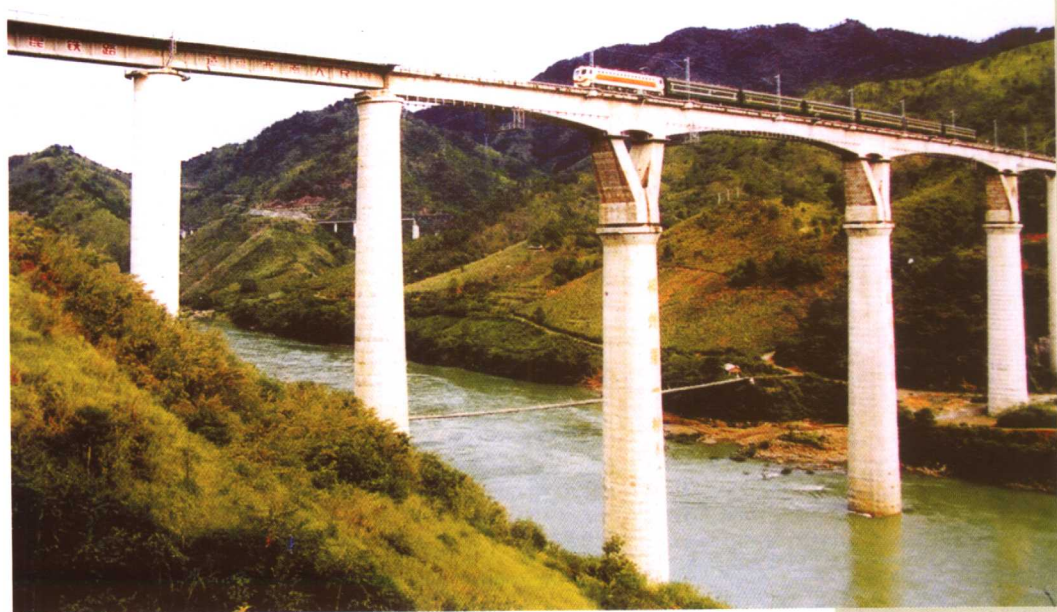
八渡南盘江特大桥
