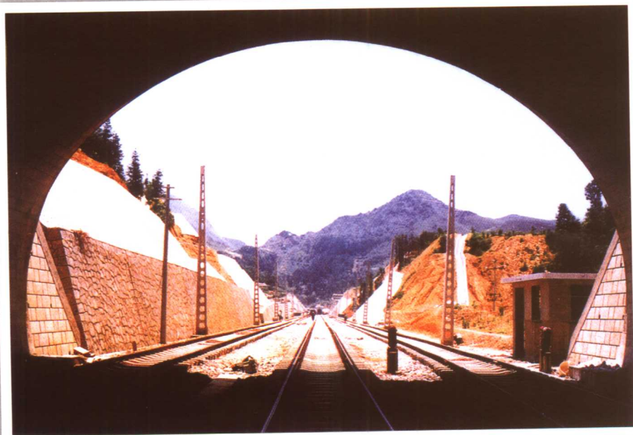
沙厂坪2号三线隧道
