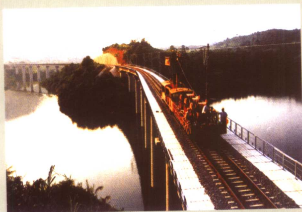
施工中的电气化工程
