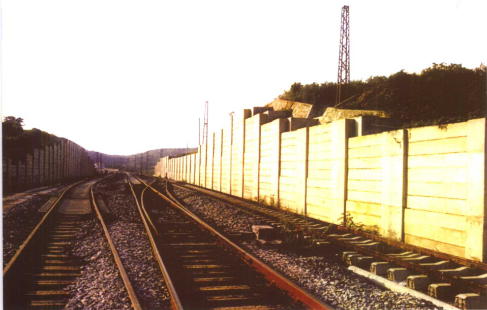
采用桩板式抗滑挡墙处理膨胀土
