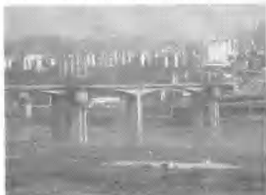
图5 石板坡大桥复线工程在施工中 （承林文修教授惠赠）
