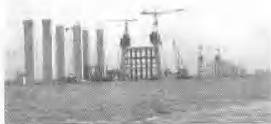
图 11 主桥桥塔和桥墩施工 (承大桥总指挥游庆仲副厅长惠赠)
