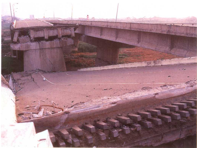
車籠埔斷層造成烏溪橋斷
