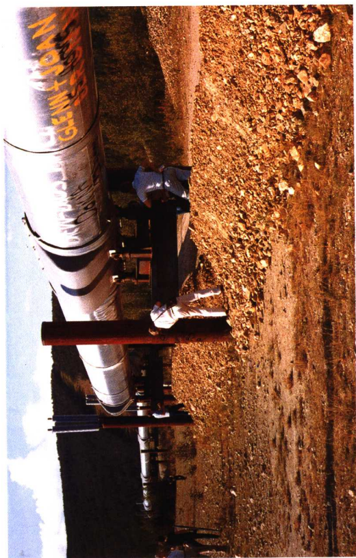
彩图 6 阿拉斯加桩架空输油管 (陈肖柏摄)
