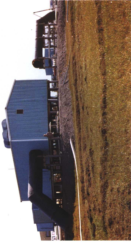
彩图 12 阿拉斯加填土架空建筑 (陈肖柏摄)
