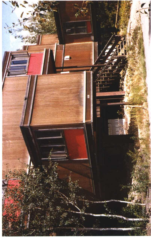
彩图 10 阿拉斯加架空式住宅建筑 (陈肖柏摄)
