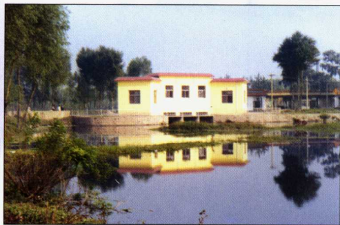
■ 汾河三坝总干进水闸
