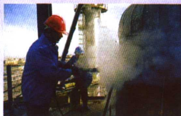
专业人员正在封堵
