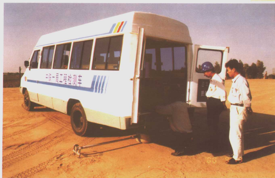
K 30 检测车进行路基检测
