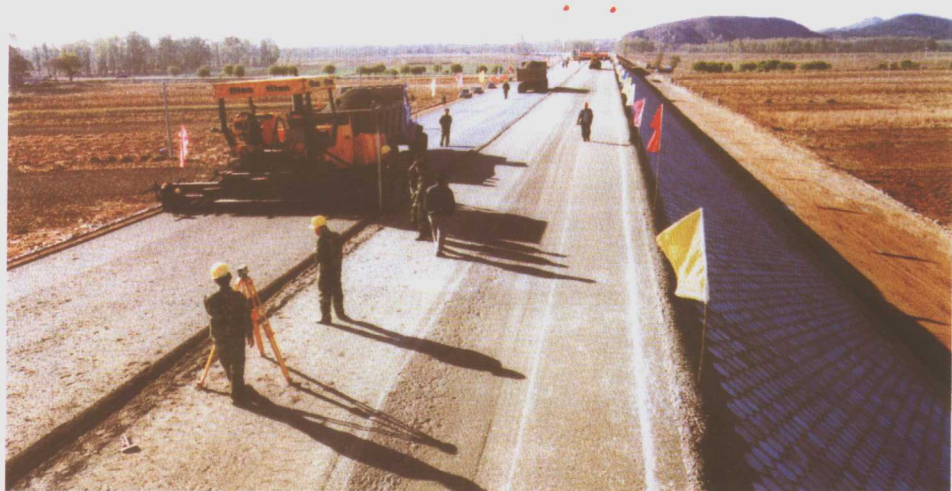
摊铺级配碎石
