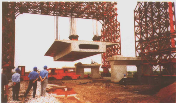
龙门吊起吊第一片24m双线箱梁
