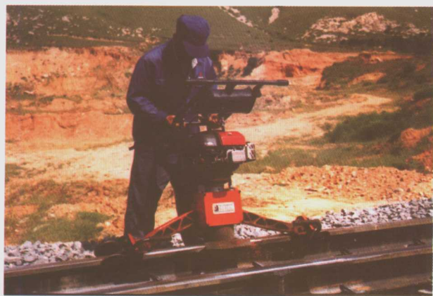
工地焊接（铝热焊）
