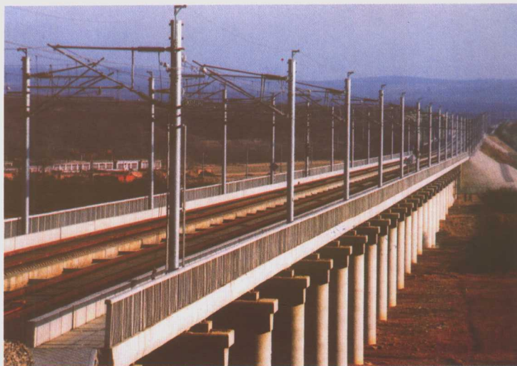
建成后的沙河特大桥
