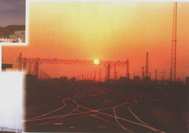
改造后的山海关站场
