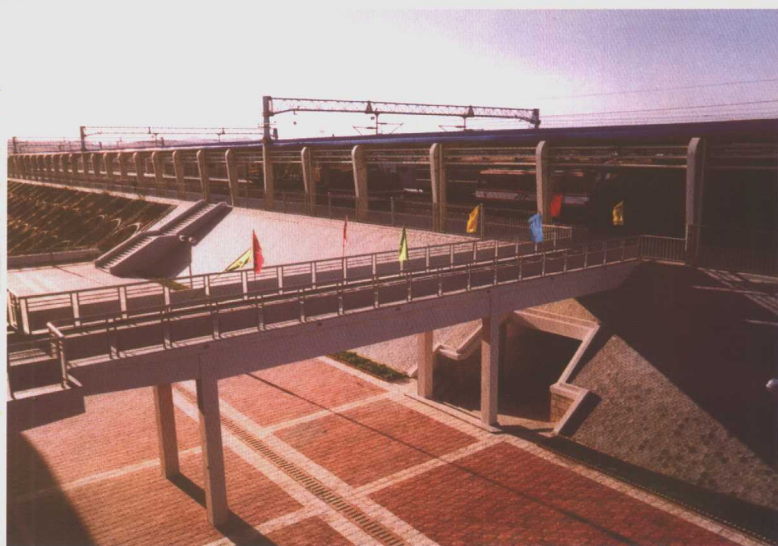
葫芦岛北站栈桥
