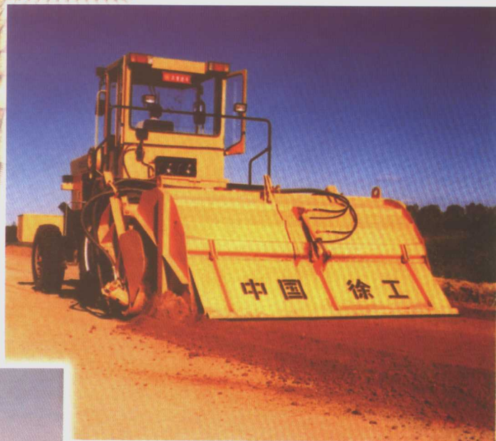
路拌机拌和中粗砂与粉黏土
