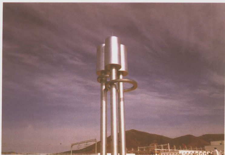
造型别致的不锈钢水塔
