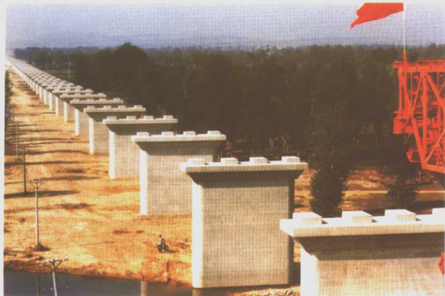
六股河特大桥
