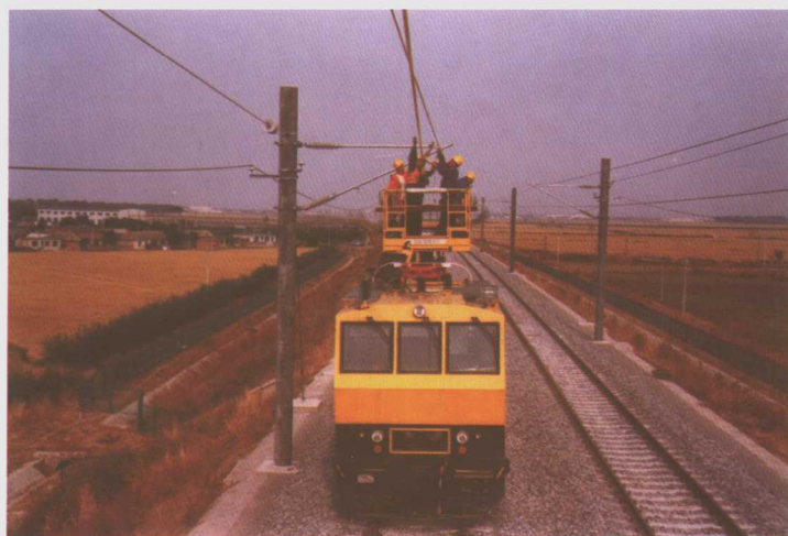
接触网施工
