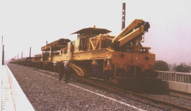
TCM60铺轨机正在作业
