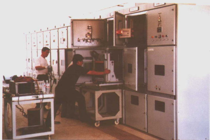
变配电所安装
