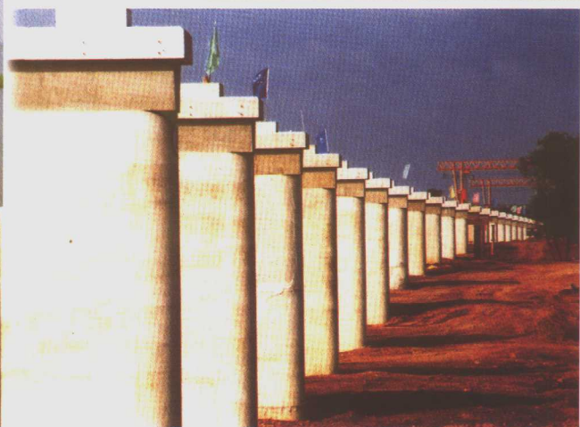
小凌河特大桥桥墩
