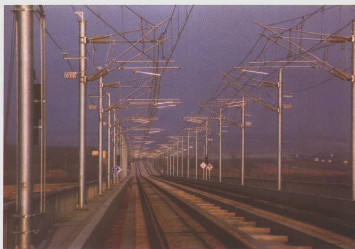
完成的接触网区间
