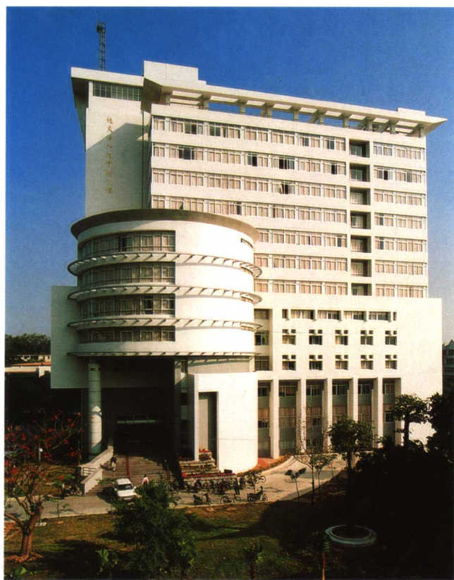
施良侨科技实验大楼
