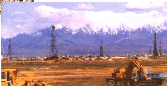
▶ 西部大开发的重要项目——西气东输工程
