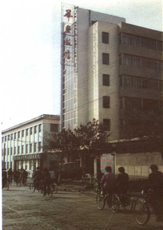
华丰饭店大楼
