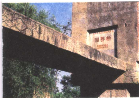
浙江嘉兴洪合国界桥局部
