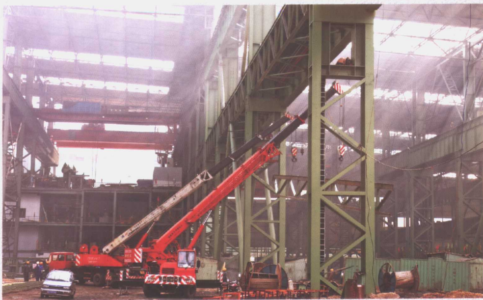
攀钢2号方坯连铸机厂房工程
