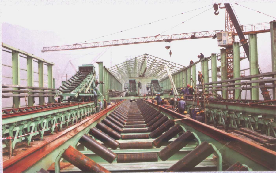
主皮带通廊安装
