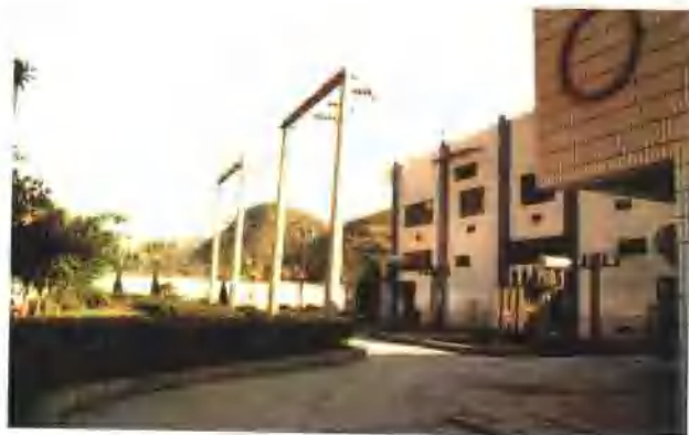
1997年5月投入运行的浦贝35千伏变电站
