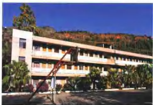
草坝电站生活区
