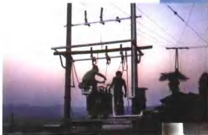
农网改造施工
