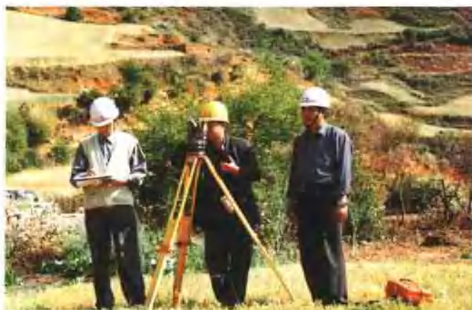
农网改造勘测线路
