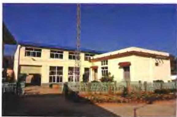
碧邦电站厂房
