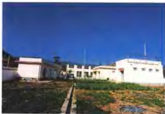
2004年12月建成投入运行的碧邦电站
