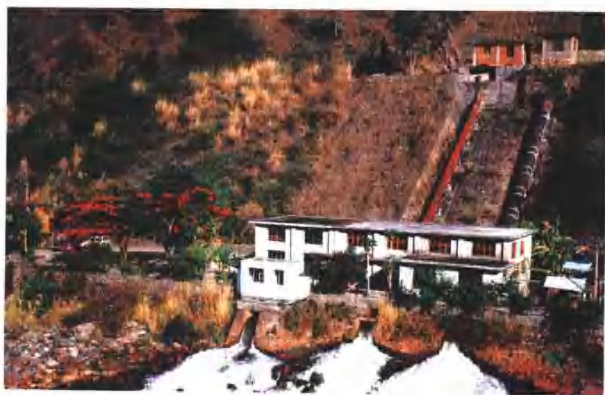
1984 年投入运 行的炉房水电站
