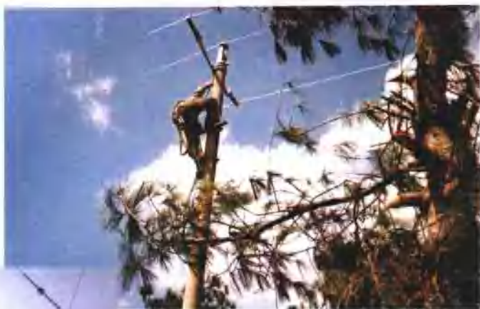
农村电网改造更新线路
