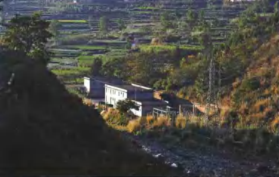
1992 年建成 投产的小草坝电站
