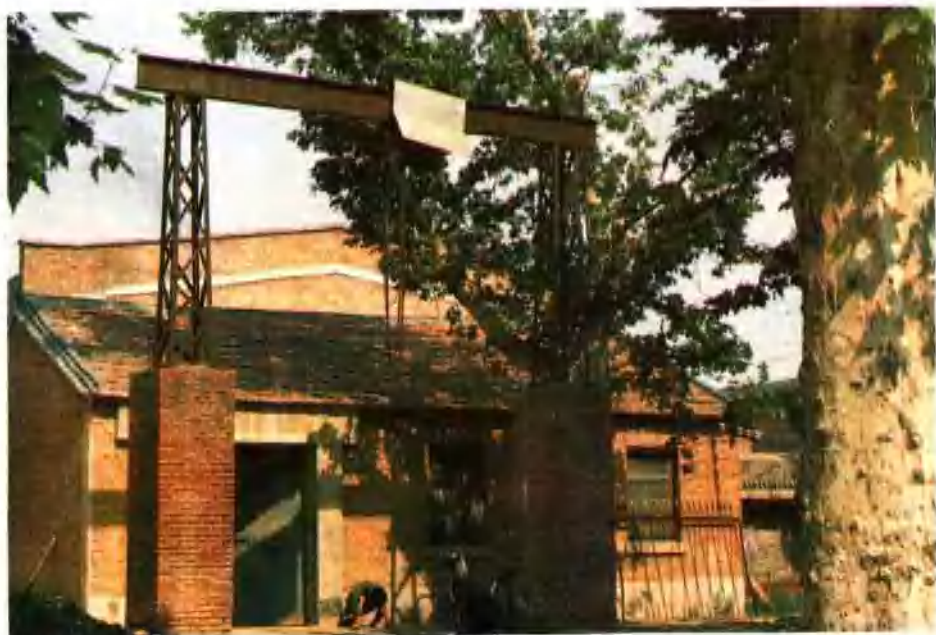
电修厂土龙门吊 1979年建
