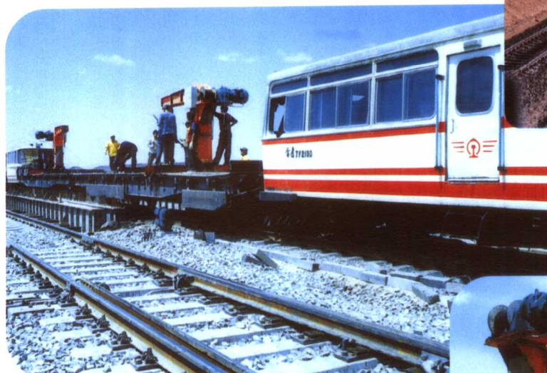
二段自制轨道车走行吊架
