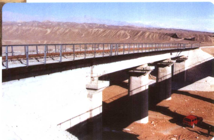
兰新线桃尔沟 3-16 米双线中桥
