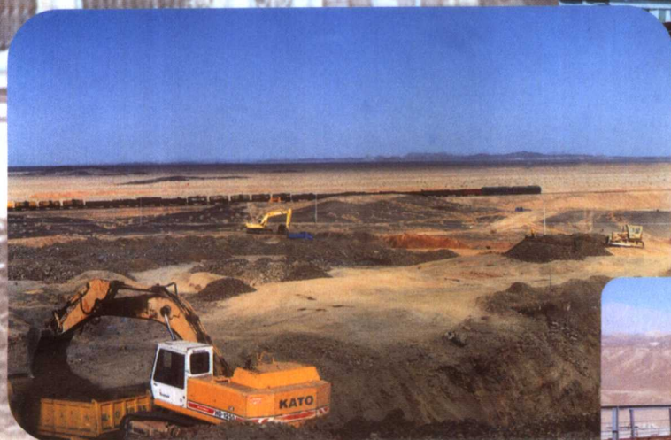
二段提速工程小半径曲线改造土方施工
