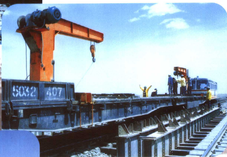
二段轨道车走行吊架设 24 米军钢便梁施工
