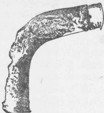
图 1. 腐蝕坏的鐵管
