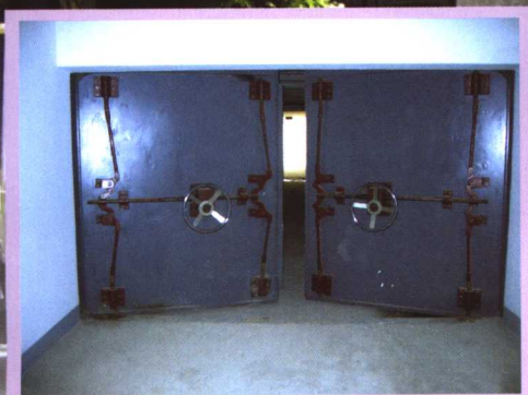
钢结构双扇活置门槛防护密闭门
