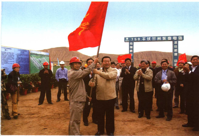
2005年5月，国家电网公司总经理刘振亚在750千伏兰州东变电站向青年突击队授旗。
