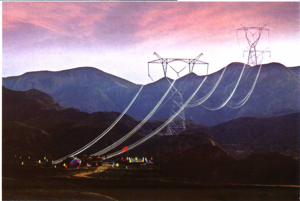
750千伏输变电示范工程架线施工。
