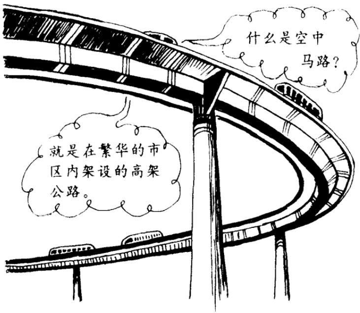
这是专门供城市汽车行驶的高速空中马路——高架路。它用单柱支撑于繁华的市区街道之上。公路宽6.5米，可以对开两辆汽车。路上没有红绿灯，行驶的汽车不许超车，不许左转弯。只在几个主要大道上，留有右转弯下到路面上和驶入高架路的路口。路旁的标志上有提示驶入高架路的汽车，不许低于所限的时速。高架公路的出现，大大缓解了繁华市区汽车行驶困难的问题。
