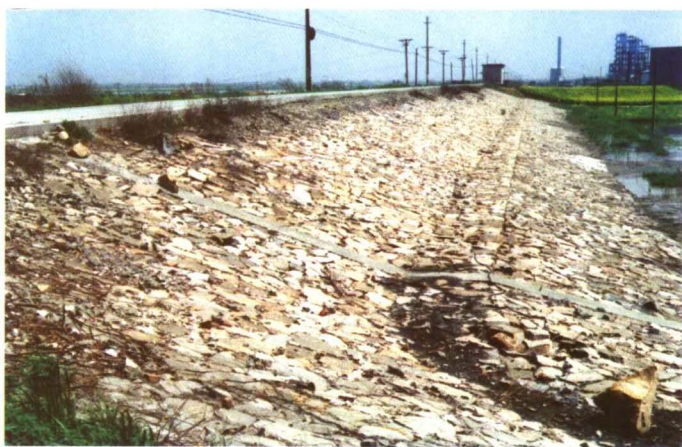
江堤块石护坡
