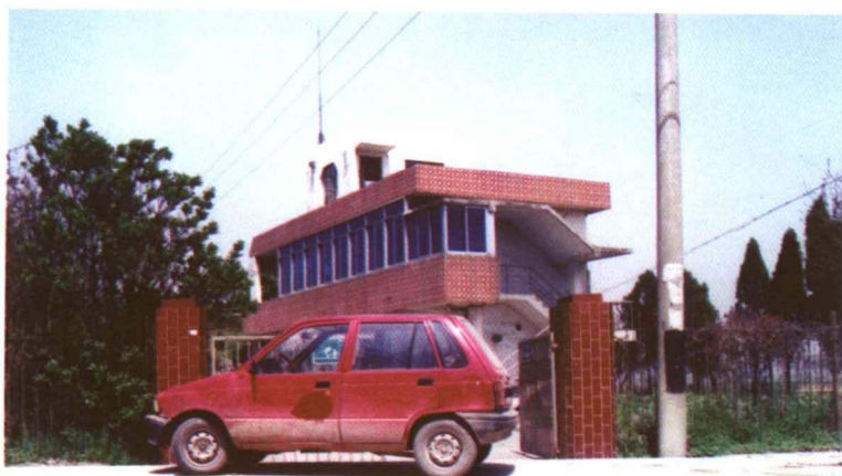
常熟电厂贮灰场管理处
