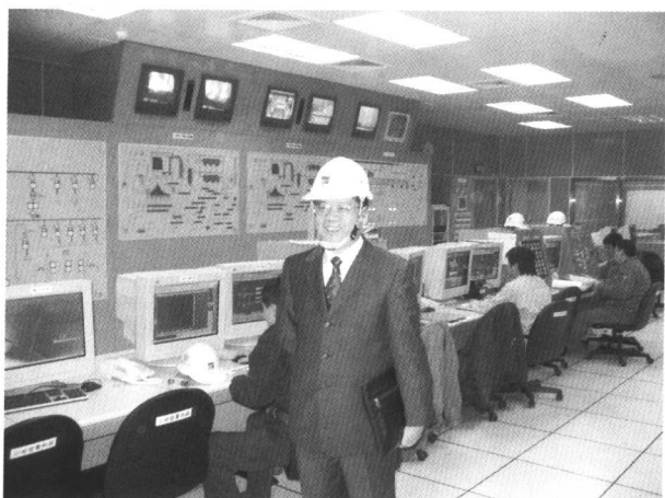
作者参观台湾医药垃圾 高温焚烧炉的控制室
