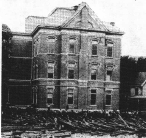
图 1-2 美国依阿华大学科学馆整体平移现场 [3]
