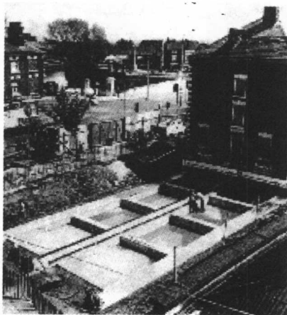
图 1-3 英国兰开夏郡 Warrington 市一座学校的平移现场 [5]
