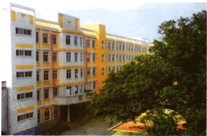
自治区示范性普通高中——平南县中学
