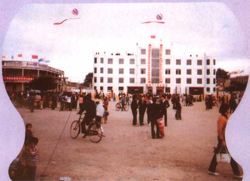
▲漳浦盐场办公科技综合大楼
