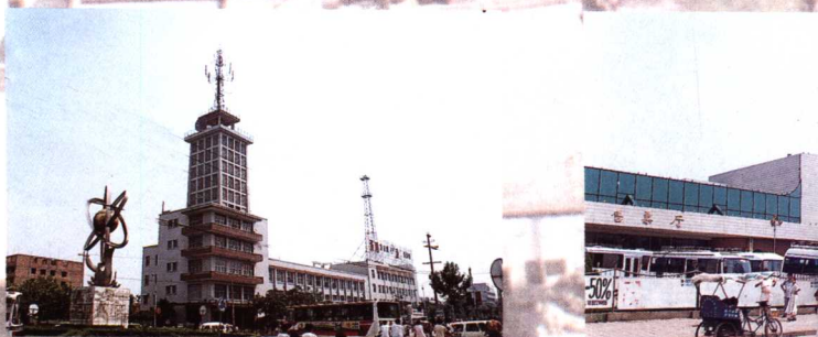
地区邮电大楼
