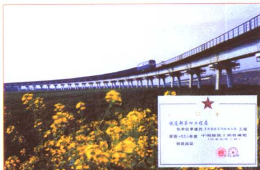
京九铁路阜阳至九江段荣获中国建筑工程鲁班奖（国家优质工程）
