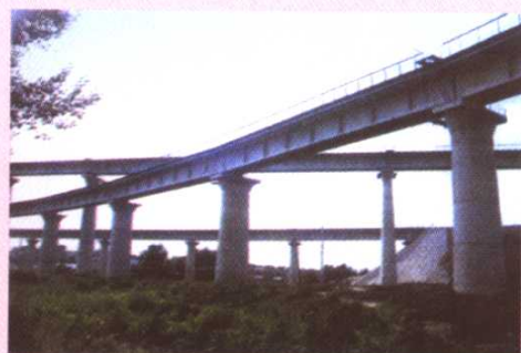
马家沟特大桥
