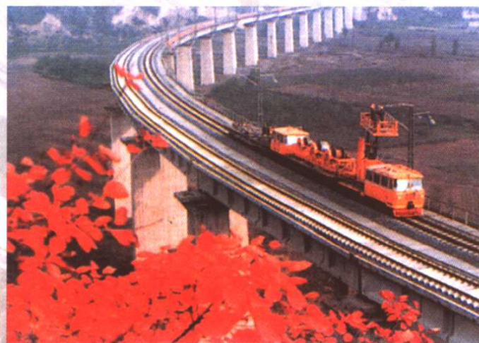
侯月电气化铁路桥上接触网架设
