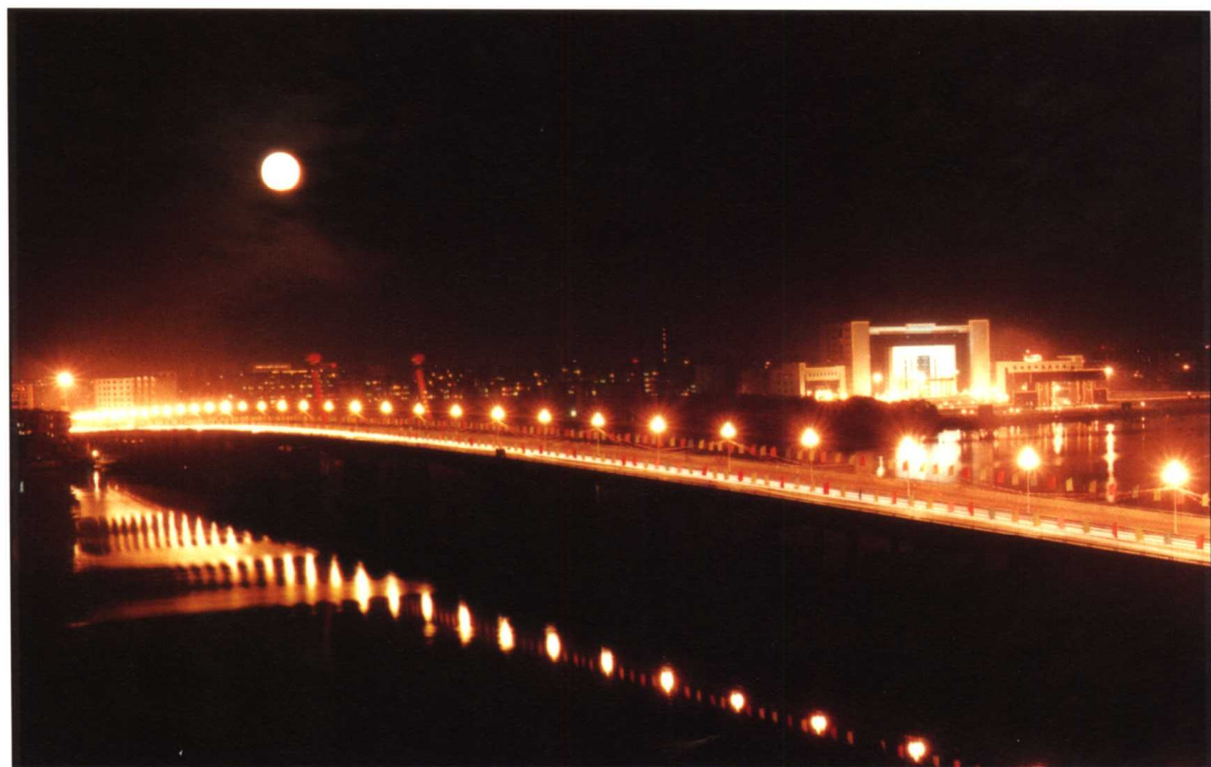
榕江大桥夜景
