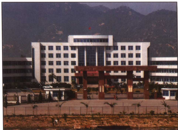
仙桥镇办公大楼
