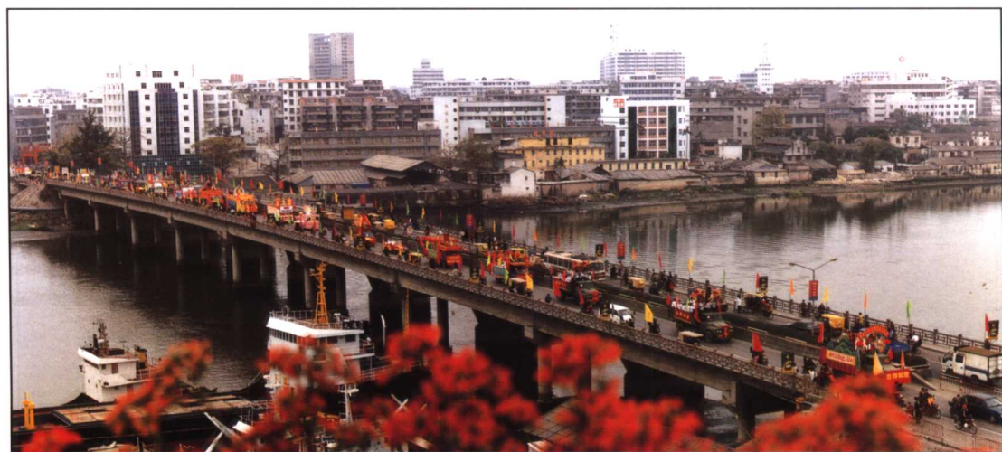
1965年建造、1991年加宽一倍的榕江北河大桥
