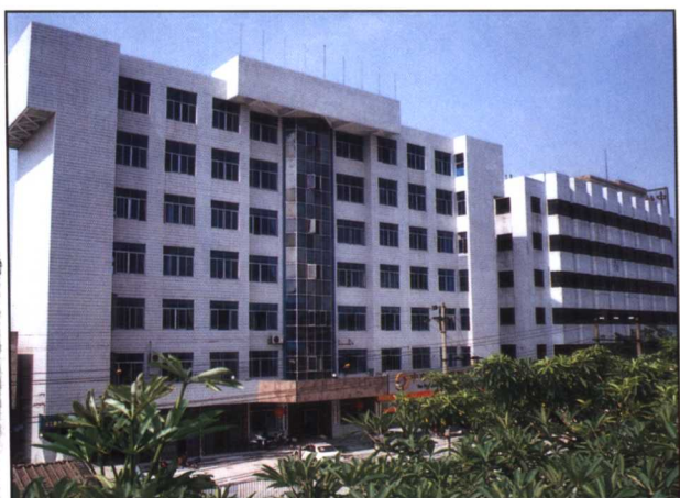
西马街道办事处办公大楼
