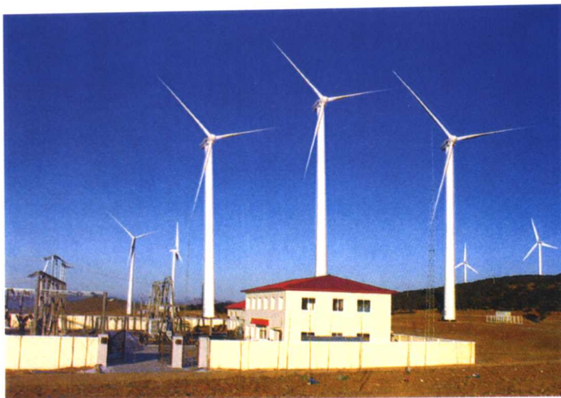
彰武县金山风力发电项目
