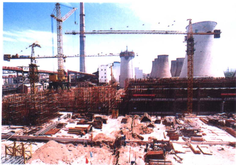
总投资28亿元的阜新发电厂三期技改工程
