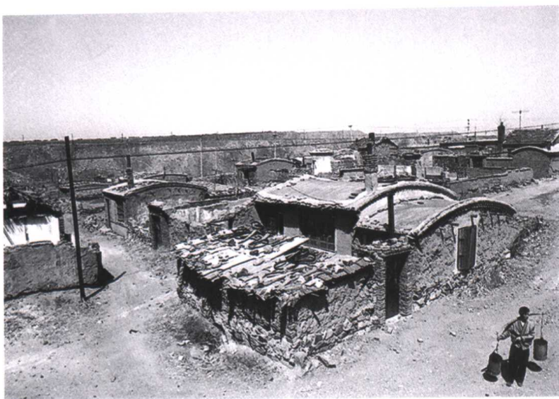
改造前的沉陷区棚户房
