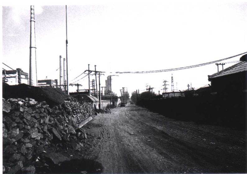
改造前的煤城路
