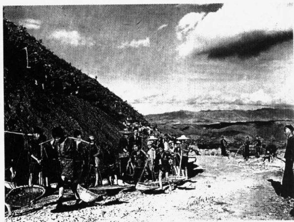
中国民众在修筑滇缅公路
