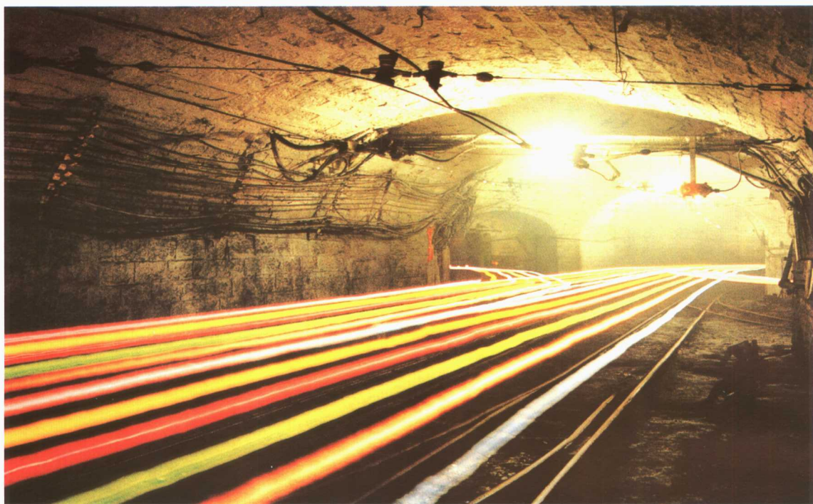
▲ 超化矿井下运输大巷
