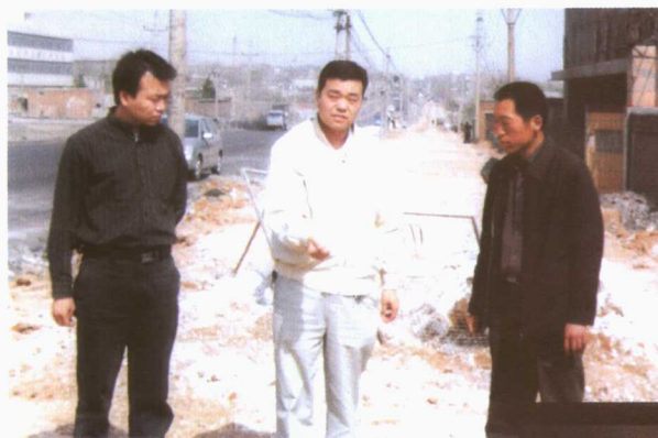
◀ 矿区交通建设局领导在工地检查工程质量
