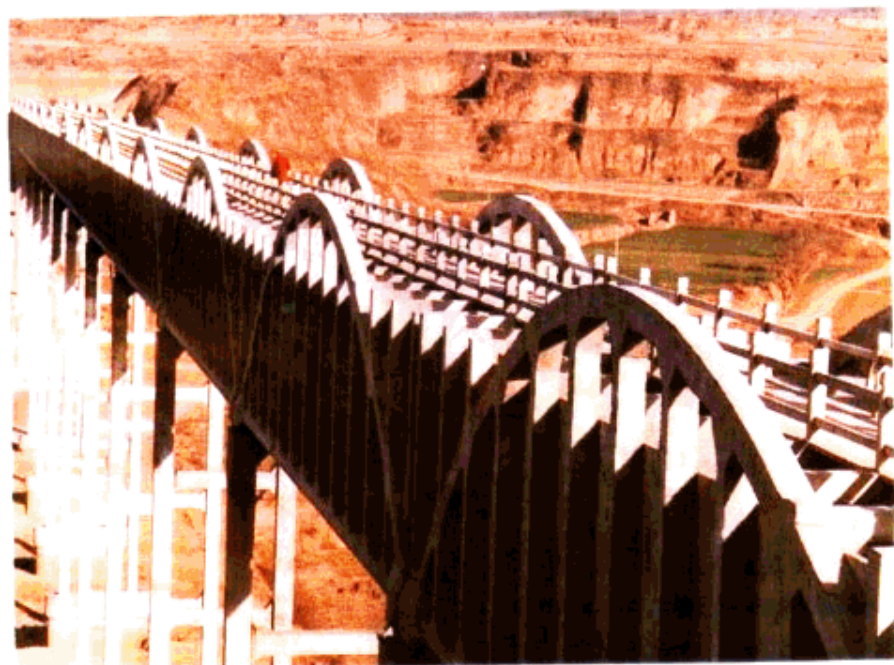
西村渡槽，长355米，过水流量24.7立米/秒
