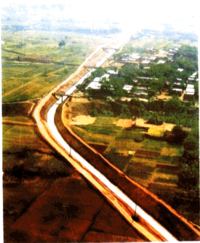
陆浑灌区东一干渠。
