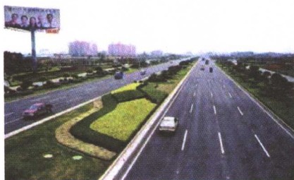
某城市入城道路
