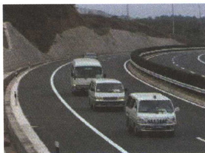
山东某高速公路
