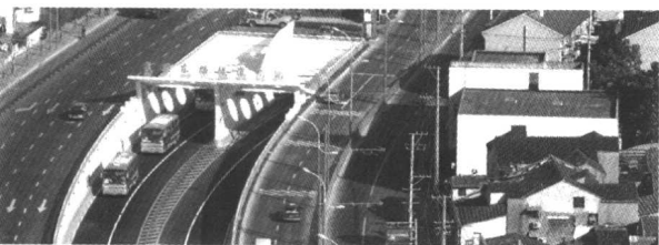
复兴东路双层越江隧道工程
