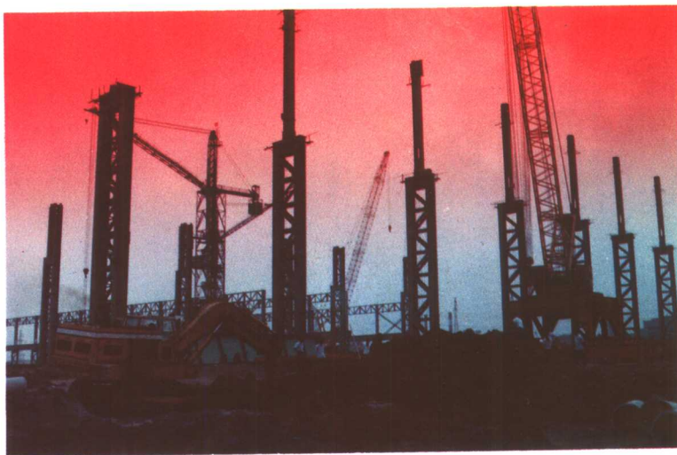
第三炼钢厂工程建设达到目标形象进度
