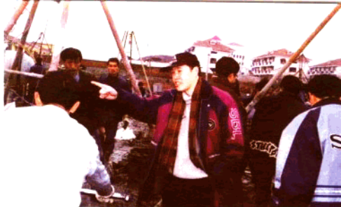
建设初期校区工程建设指挥长朱跃钊 校长助理(现为副校长)指挥厚学楼桩 基施工
