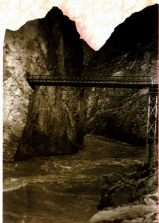
怒江大桥（上为旧桥）。旧桥为1953年11月1日建成的双排双层贝雷钢桁梁架桥；新桥为1972年12月29日建成的钢筋混凝土双曲拱大桥。
