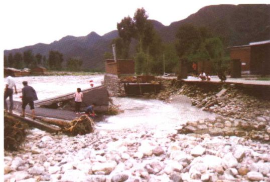
1994年7月12日平谷县暴雨洪水冲毁公路，冲走树木
