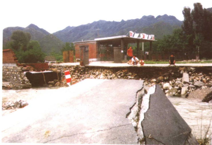
1994年7月12日，平谷县暴雨洪水冲毁公路
