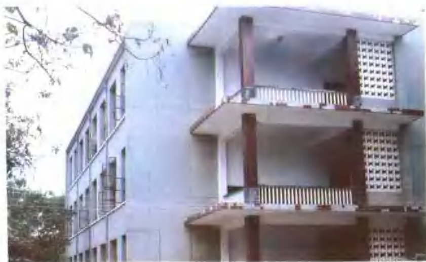
⑱县高中实验楼
