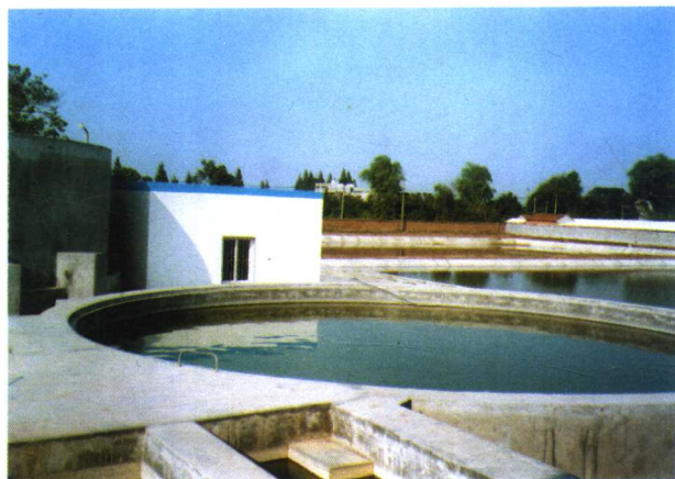
蓄水池、泵房和催产池
