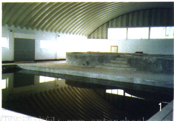
孵化环道和集苗池
