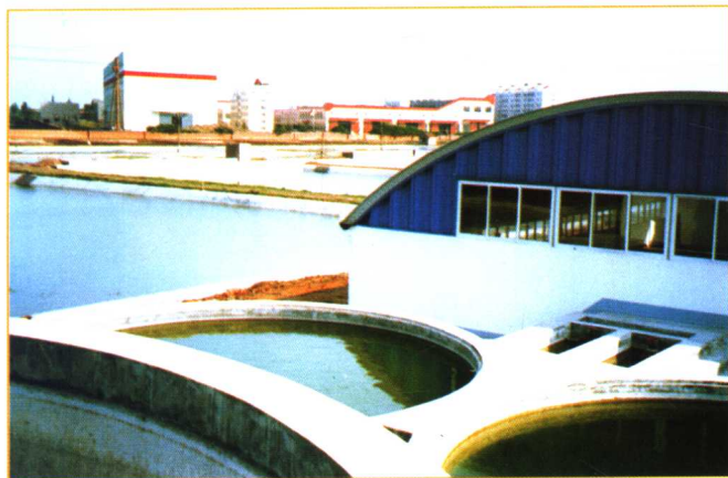
孵化设施 设备一角
