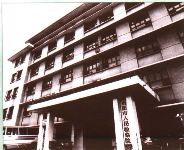
1982年4月至1999年10月的贵阳市人民检察院办公大楼
