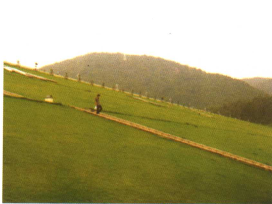
水库大坝草坪（假俭草，深圳）
