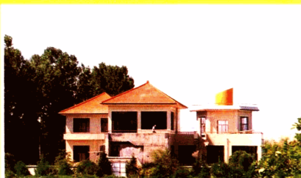
在建的东郊公园接待厅
