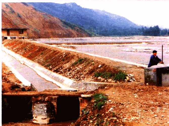
南川渠改扩建工程——进水口
