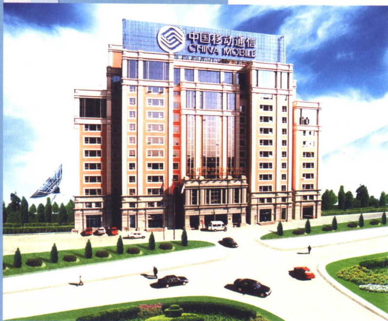
北京移动通信有限责任公司智能管理办公大楼。
