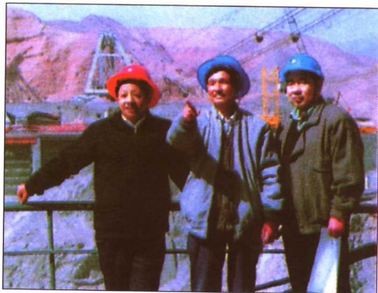
黄河上游水电工程建设局领导深入施工现场解决问题
