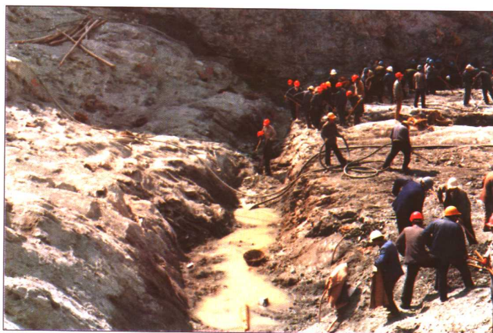
李家峡水电站坝基 (9# 坝段) F 1 断层挖掘 情景
