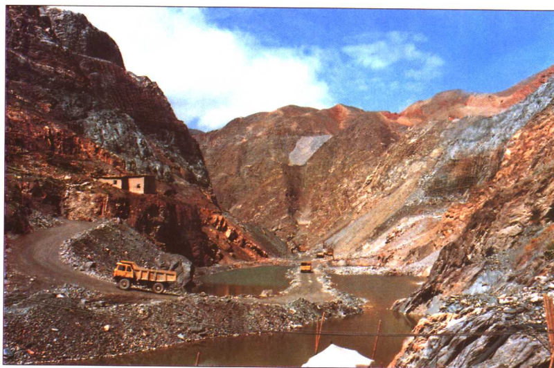
李家峡水电站 基坑开挖施工
