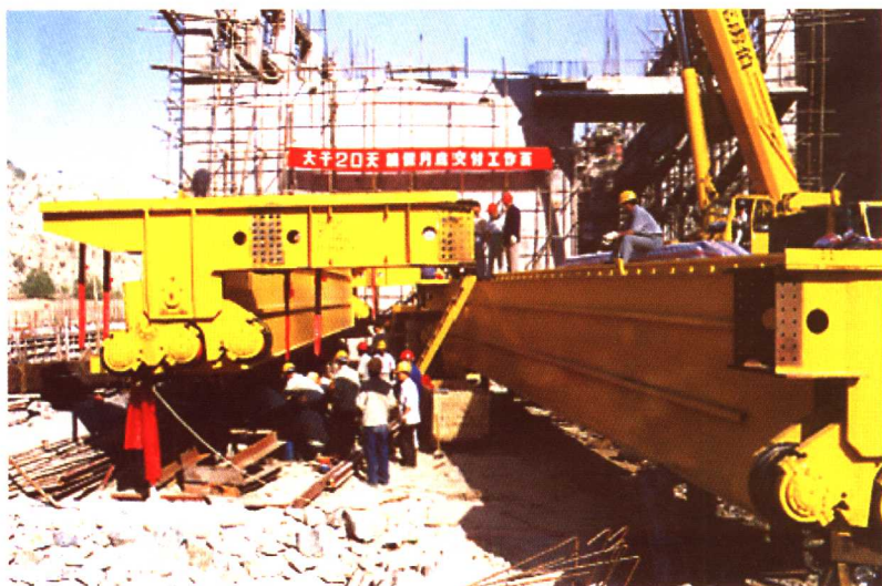
24米桥吊安装施工
