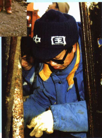
中国第三次南极考察队队长郭琨在长城站海湾落潮的时候，同队员一起抓紧整修长城站码头的钢桩地基。
