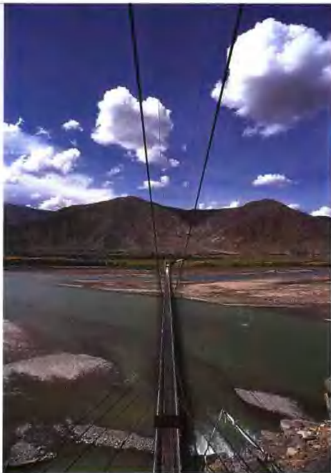
由西藏自治区交通厅自行设计、施工的达孜吊桥
