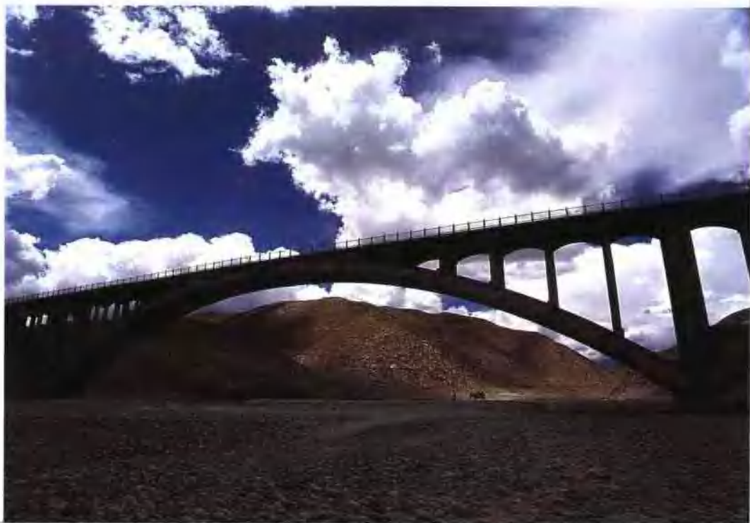
中尼公路上的尼木大桥
