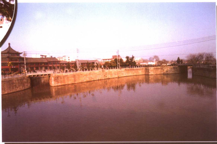
清江大闸。明永乐十三年（1415年）平江伯陈瑄建，万历十七年（1589）年，又在大闸西北建一越闸，为正闸之副。两闸全部用长方形条石砌成
