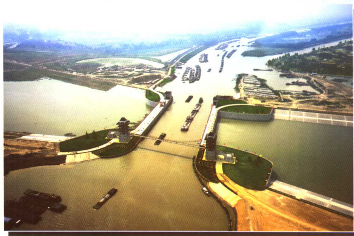
淮河入海水道淮安枢纽
