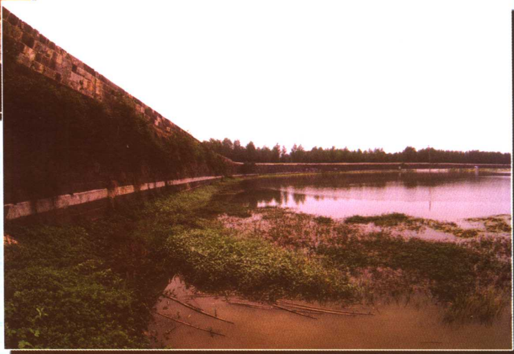
洪泽湖大堤直立式石工墙
