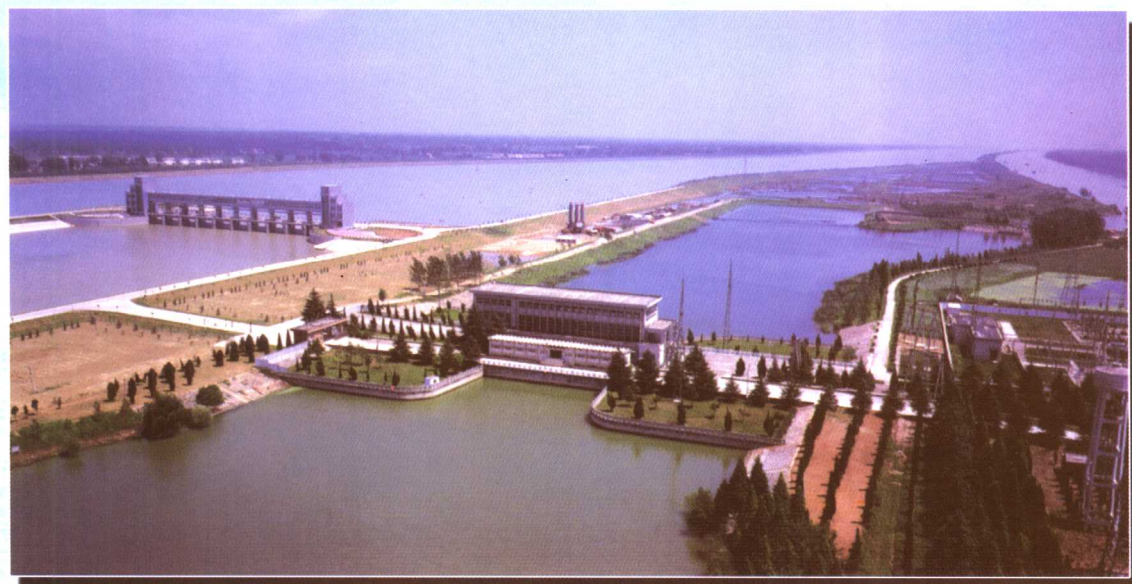
淮河入海水道二河枢纽
