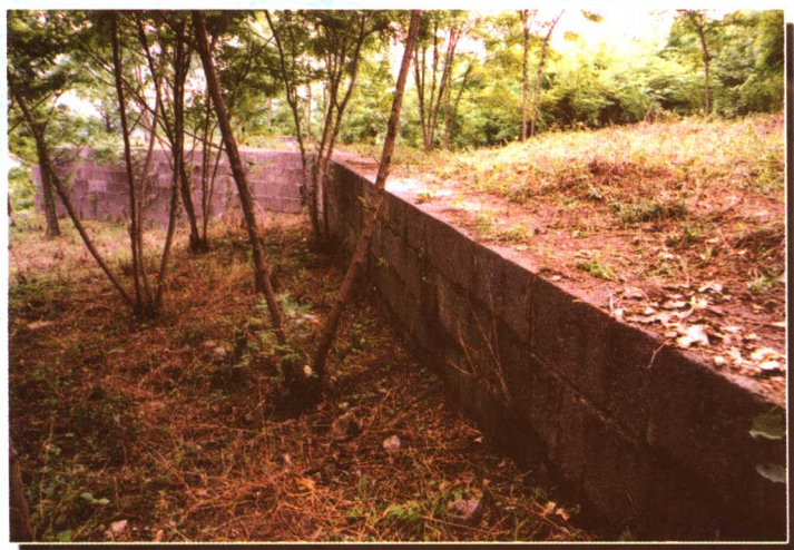
洪泽湖大堤“仁”字减水坝。建于乾隆十六年（1751年）
