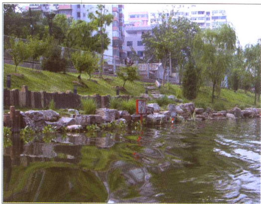
乱石生态护岸的建立，使人工护岸更接近天然河流
