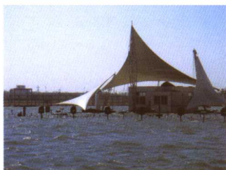
音乐喷泉控制室
